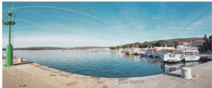
Na lokalitetu Punčala u puntarskoj luci do sezone 2019. bit će izgrađen novi mul, a obnovit će se i obalni zid
