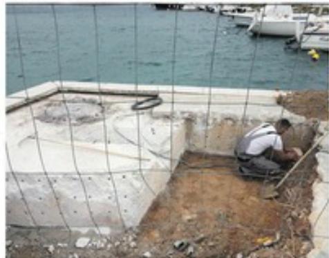
Radovi na gradnji postolja za dizalicu u luci Malinska
