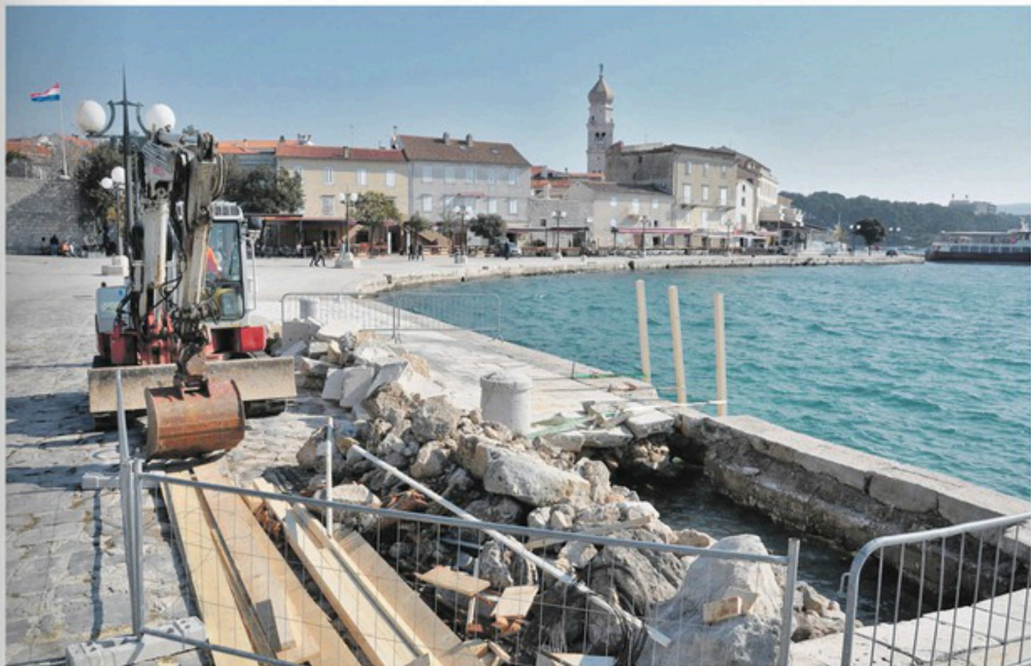
Sanacija oštećenog Ribarskog gata u krčkoj luci trajat će do 1. svibnja, a nastavak obimnijih radova slijedi nakon sezone
