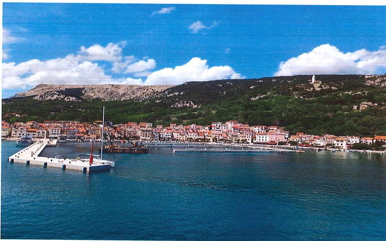
Slika 2: Luka Baška – rekonstrukcija luke Baška – III. faza
